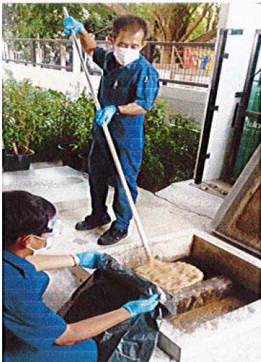
ภาพที่ 1-8 เจ้าหน้าที่ดักไขมัน และมิเตอร์ไฟฟ้าสำหรับระบบบำบัดน้ำเสีย
