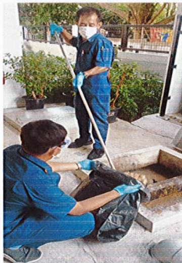
ภาพที่ 1-8 เจ้าหน้าที่ดักไขมัน และมิเตอร์ไฟฟ้าสำหรับระบบบำบัดน้ำเสีย
